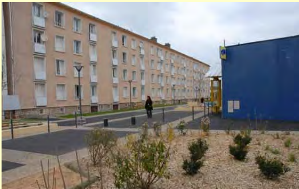
Réhabilitation de la place du marché à Bel Air
