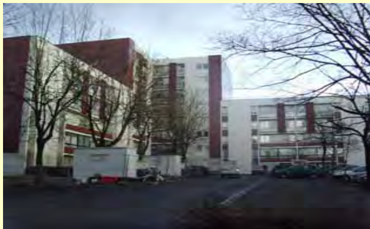
Réhabilitation en cours sur «l'îlot Jean Moulin»
