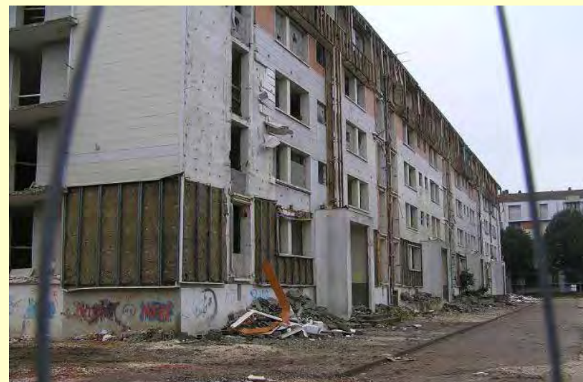
Barre G en cours de démolition
