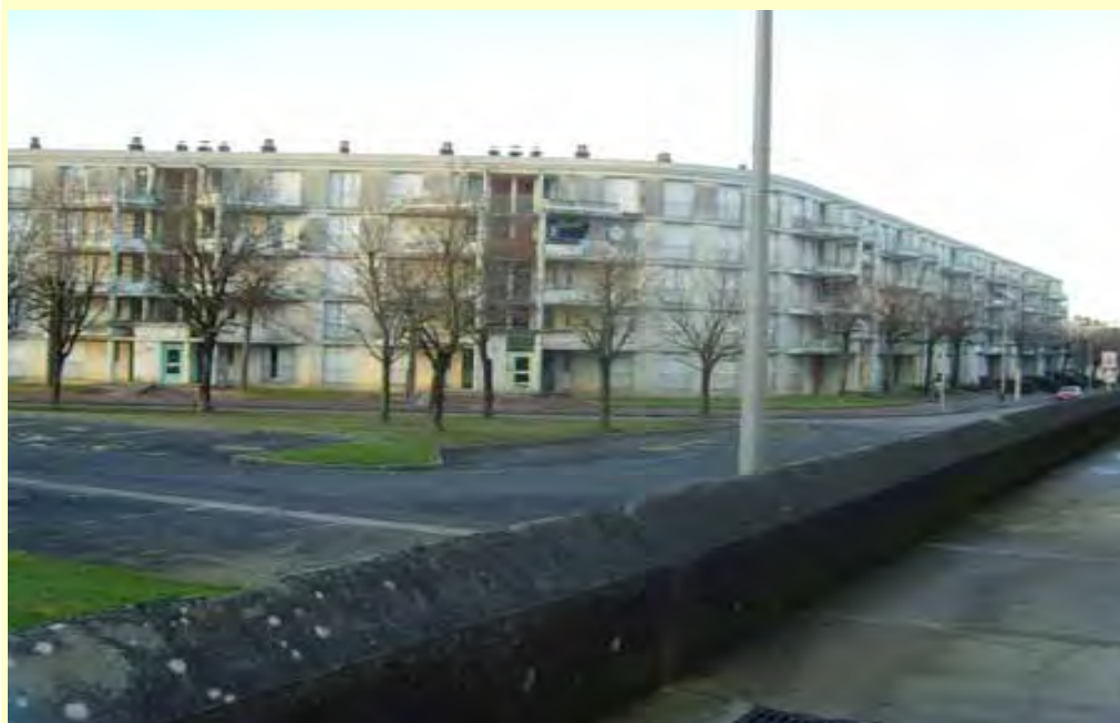
Barre prévue pour être démolie
